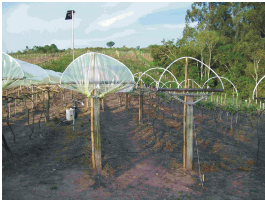
Figura 7. Estrutura do “Y” montada no campo, com a opção pelo cultivo protegido, com estrutura dos braços do “Y” montada em ferro complementada com madeira, arco sustentado por estaca de bambu, ancoragem e cobertura plástica.
